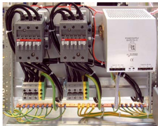
AC входная панель с аварийными контакторами AC input panel with emergency off contactors
